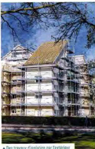
▲ Des travaux d'isolation par l'extérieur.
