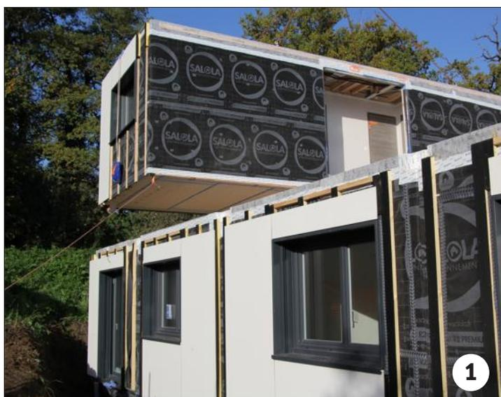
TH est actuellement en train de livrer quatre maisons à Héry-sur-Alby (Haute-Savoie). Les modules sont assemblés directement sur site, les fluides sont déjà intégrés. Plus besoin d'attendre le plaquiste ou l'électricien, etc. Photo TH
